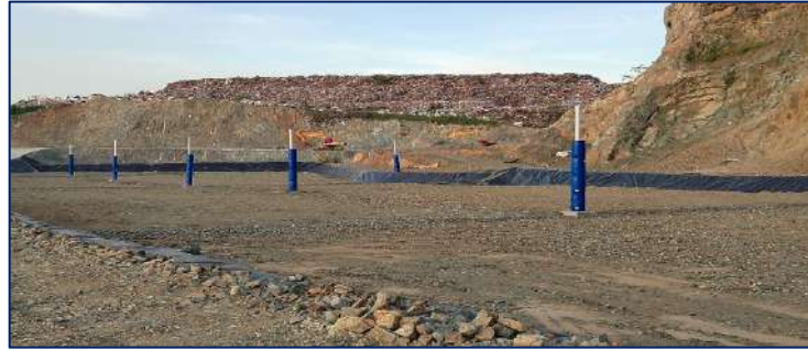
Doc: Lokasi Pembangunan Landfill Baru TPA Kebon Kongok baru saja Selesai dikerjakan di Dusun Bongor Desa Taman Ayu Ket: 1. Pipa yang terlihat berjajar berfungsi sebagai saluran gas yang dilepaskan ke udara 2. di bawah timbunan tanah, terpasang instalasi pipa yang berfungsi mengalirkan air
